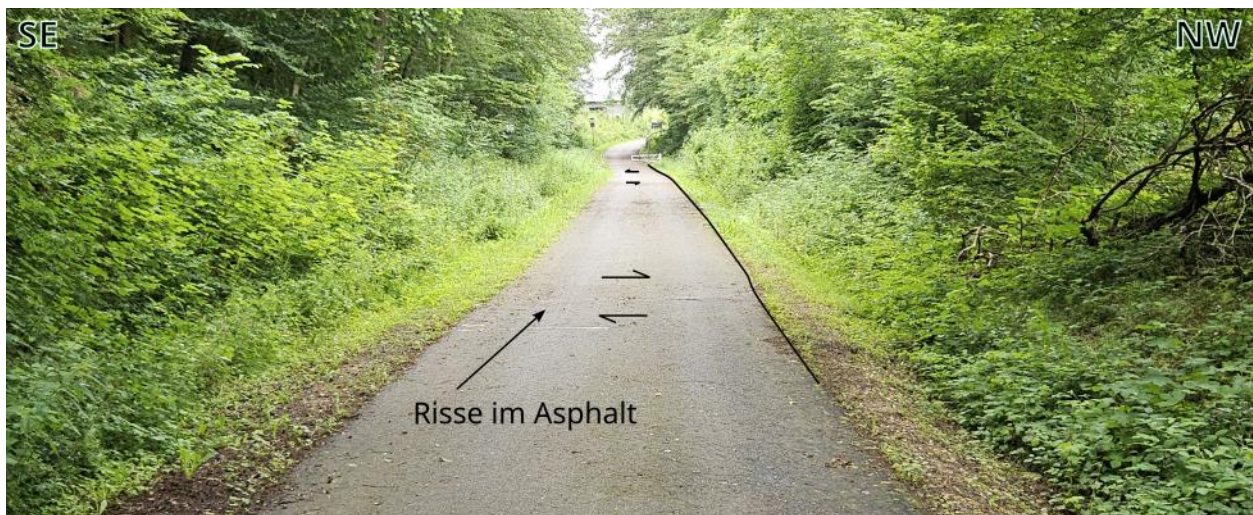
Abbildung 2: Verschiebung in der Achse des Radwegs im Bereich der Rutschung.
